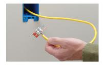
2. Determine wiring scheme. Dress all 4 pairs (8 wires).
