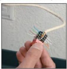
Determine wiring scheme. Dress all 4 pairs (8 wires).
